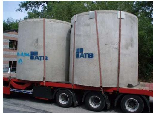
Il est également possible que le camion soit équipé d'une grue de levage et décharge directement la cuve dans la fouille. Les abords de la fouille devront dans ce cas être dégagés, notamment pour permettre au camion d'étendre ses béquilles sur une largeur de 4 à 6 mètres, afin d'assurer l'équilibre statique du camion lors du levage de la cuve.
